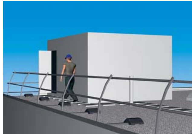
Bild 17 Flachdach mit Dachrandsicherung
